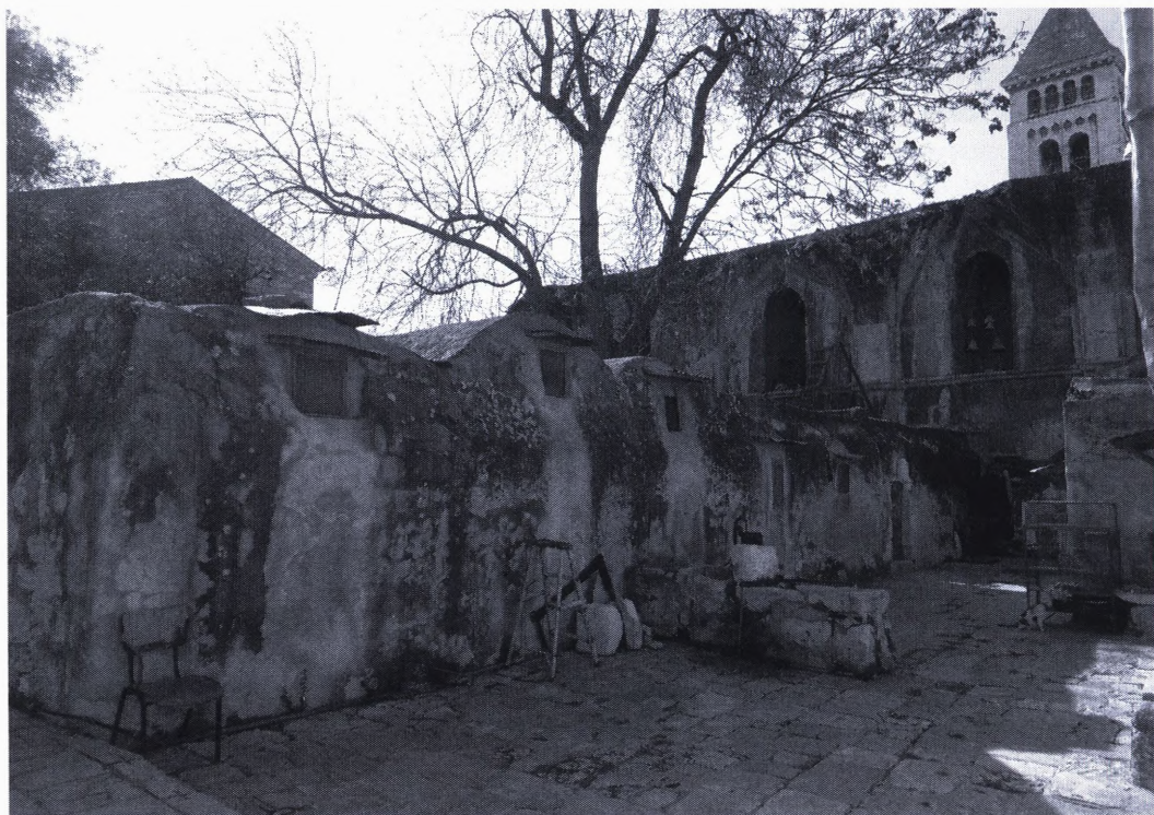
Kamienne zabudowania etiopskiego klasztoru Debre Sultan na dachu bazyliki Grobu Bożego
