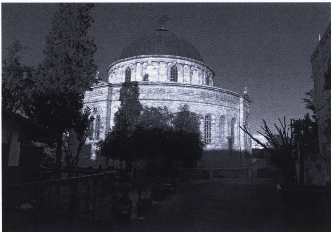
Charakterystyczna rotunda Kościoła Kidane Mehret przy ulicy Ethiopia w Jerozolimie
