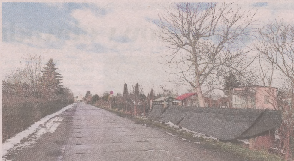
Odcinek ulicy Banacha, który będzie modernizowany. Po prawej ogrodzenie ROD „Kolejarz”, które będzie przesunięte o 5 metrów w głąb działek
