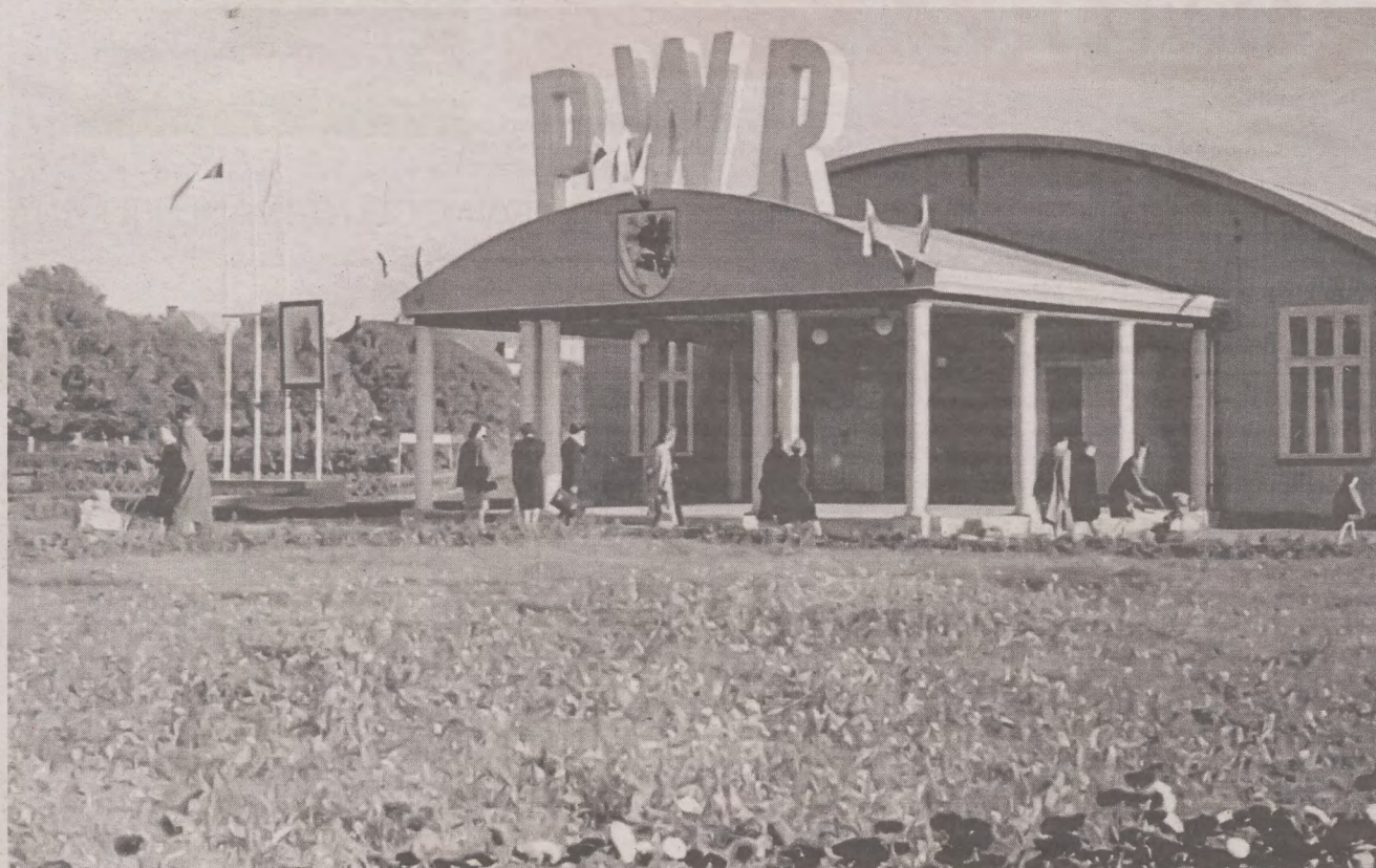
Hala postawiona była na potrzeby Powiatowej Wystawy Rolniczej na błoniach za stadionem
