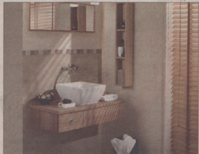
Łazienka tynkowana: tynk strukturalny, pomalowany żywicą w okolicach umywalki.
