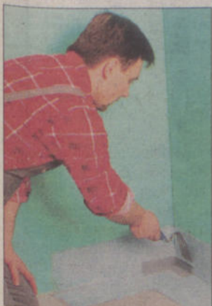
Taśmę uszczelniającą kleje się na połączeniu ścian z podłogą i w narożnikach.
