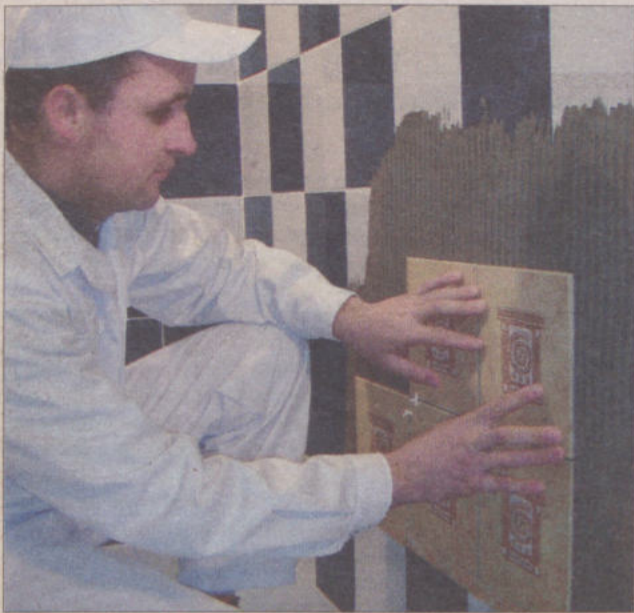
Układanie nowych płytek na stare oszczędzi nam trudu skuwania starej ceramiki.
