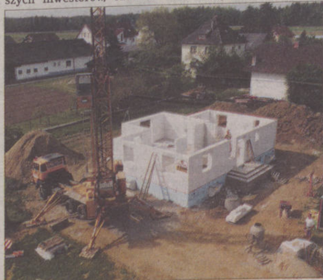
Zatrudnienie sprawdzonego wykonawcy generalnego da nam większą gwarancję, że prace wykonane będą rzetelnie i na czas. Jest to jednak najdroższe rozwiązanie. Fot. materiały prasowe Xella
