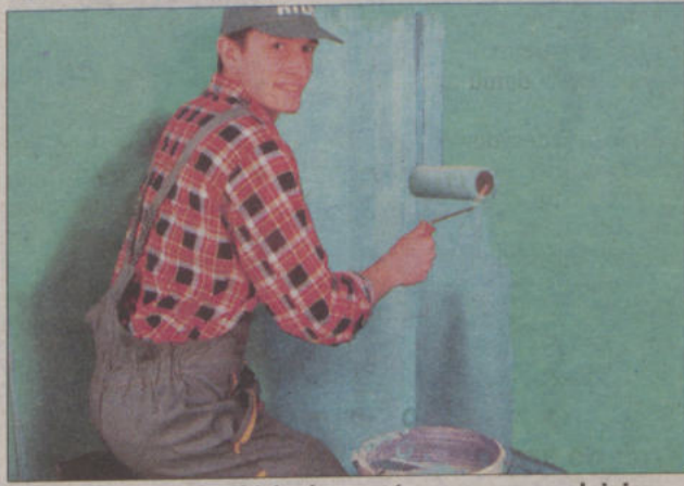
Po wklejeniu wszystkich elementów, masę uszczelniającą rozprowadza się na całej powierzchni ściany.
