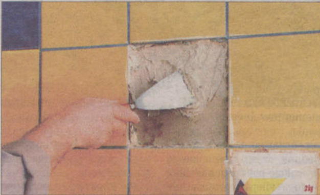
Na oczyszczone podłoże nakładamy klej dyspersyjny Atlas Bis. Jest on produkowany jako gotowa do bezpośredniego użycia jednorodna pasta, nie ma zatem problemu z przygotowywaniem mieszanki i bałaganem.
