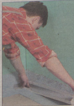
Wklejanie wyprofilowanego narożnika przy pomocy masy uszczelniającej.
