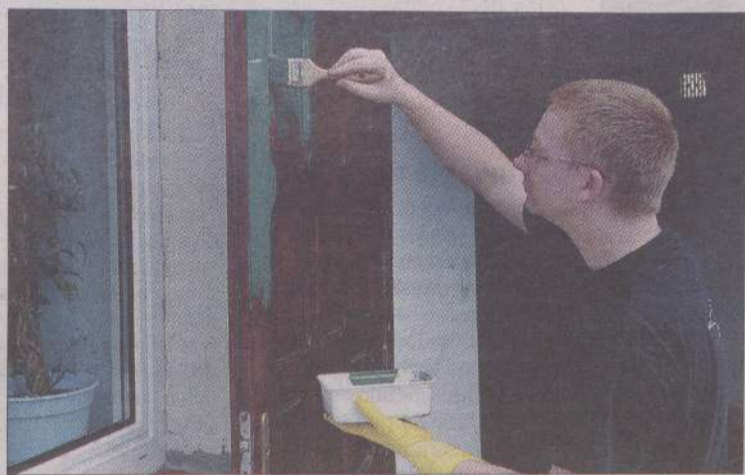
Ciepłe dni to dobra pora na przeprowadzenie konserwacji drewnianych elementów domu.
