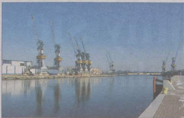
Przebudowa nabrzeża portowego realizowana przez Doraco.
