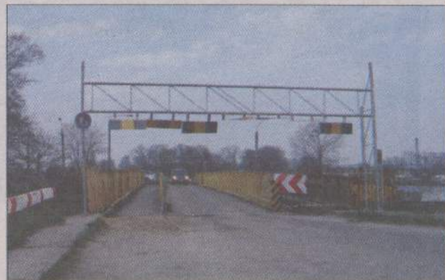
Most „bezpieczeństwa” w Przegalinie - jedyna stała droga ewakuacji dla 3,5 tysiąca mieszkańców gdańskiej Wyspy Sobieszewskiej.
