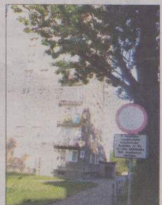
„Dojazd” do wieżowca w Tczewie.
