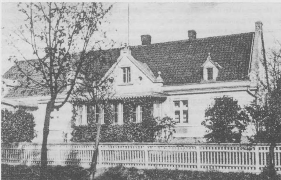
W tym domu w czasach I wojny światowej znajdowało się kasyno wojskowe
