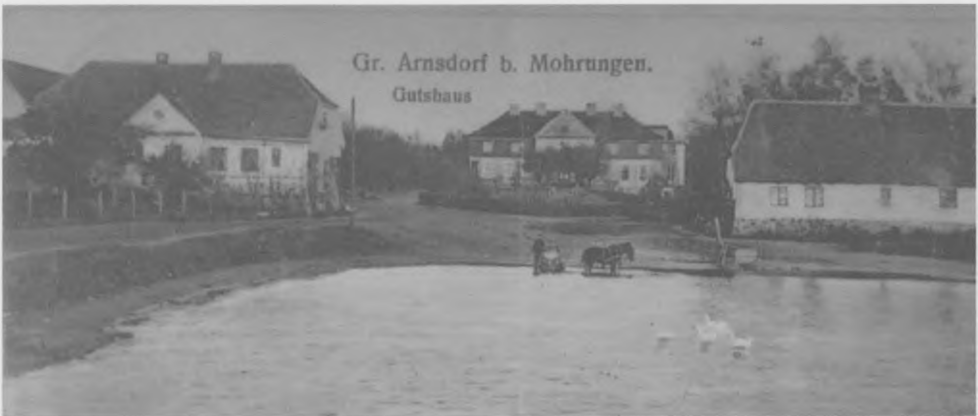
Kopia z pocztówki z roku ok. 1920. Po lewej, istniejący do dziś budynek zarządcy dawnego majątku ziemskiego. W środku wybudowany w 1770 r. przez Jerzego von Hülsena, ucznia Kanta, pałacyk jarnołtowskiego majątku. Po prawej nieistniejący dziś budynek będący domniemaną siedzibą właścicieli dworu w okresie poprzedzającym budowę pałacyku – prawdopodobne miejsce, w którym nauczał Immanuel Kant.
