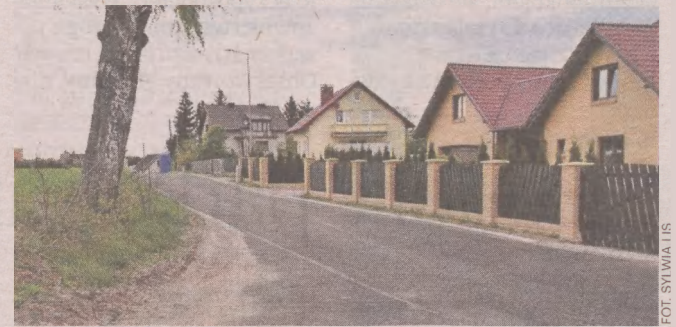
Droga w Ugoszczy była niedawno remontowana
