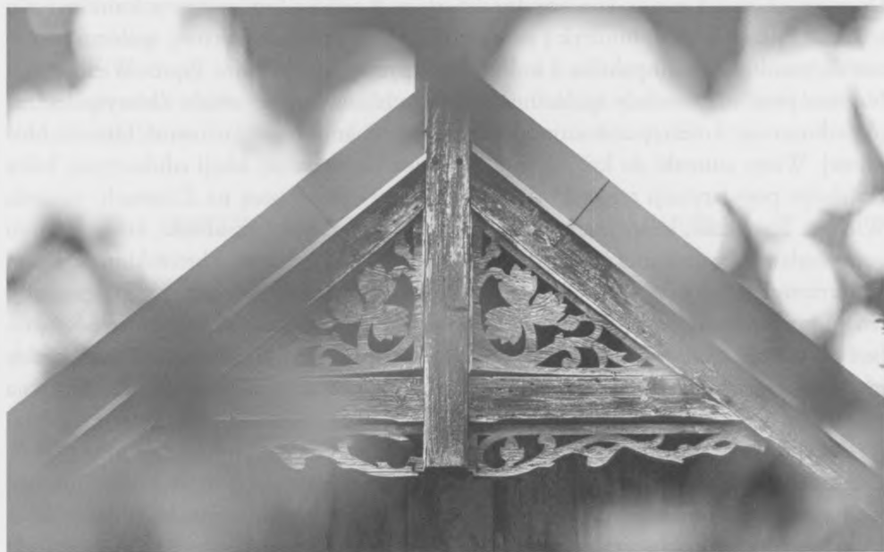
Detale architektury drewnianej, fot. Mateusz Włoch
