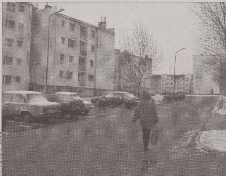
Ulica Domańskiego na osiedlu domów wielorodzinnych, gdzie ma przebiegać mała obwodnica Bytowa od ul. Gdańskiej do wylotu na Kościerzynę
