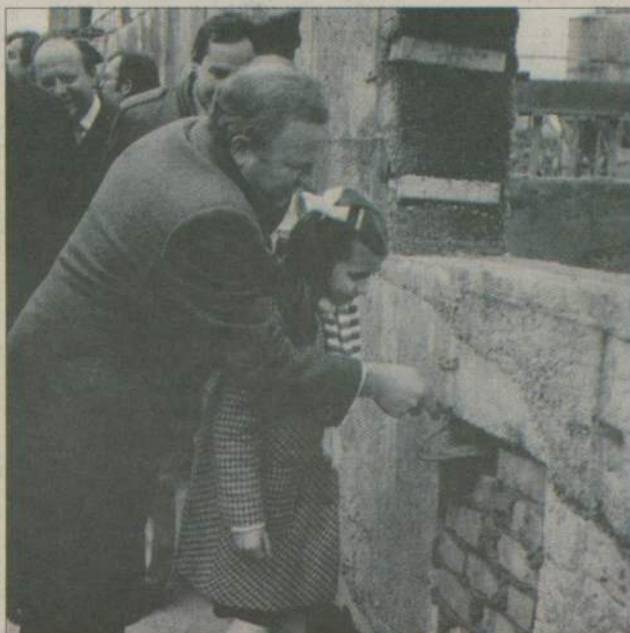
W uroczystościach wmurowania kamienia węgielnego pod budowę nowej siedziby Szkoły Podstawowej nr 1 w 1983 roku uczniów reprezentowała Katarzyna Rekawska.
