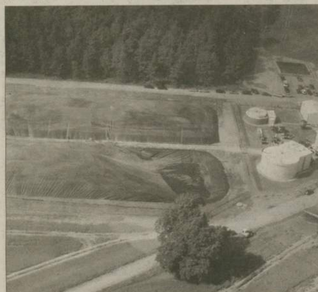
Tak z lotu śmigłowca prezentuje się biogazownia i laguny z gnojowicą przy fermie w Pawłówku.
