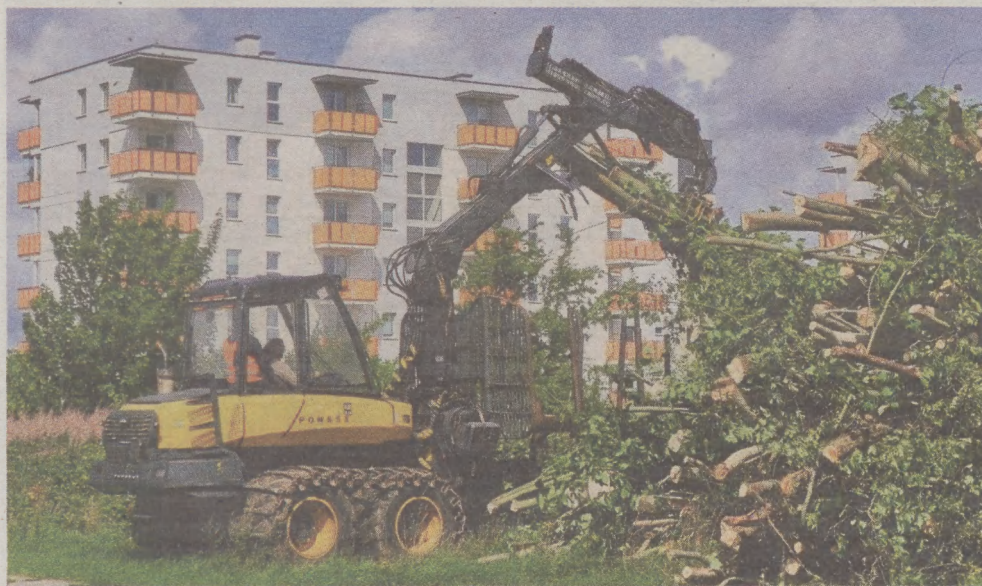
Przygotowanie terenu pod budowę zbiornika retencyjnego u zbiegu ulic Zaborowskiej i Legionów Polskich
