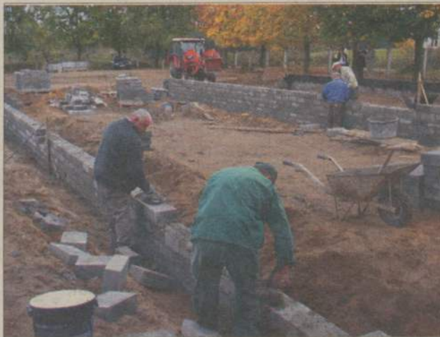
Trwają prace przy budowie łącznika między szkołą i projektowaną halą sportową. Na tę ostatnią trzeba będzie poczekać trochę dłużej.
