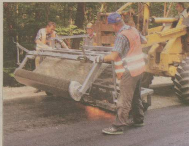
Firma wykonująca roboty poszerzyła drogę i utwardziła pobocze.
