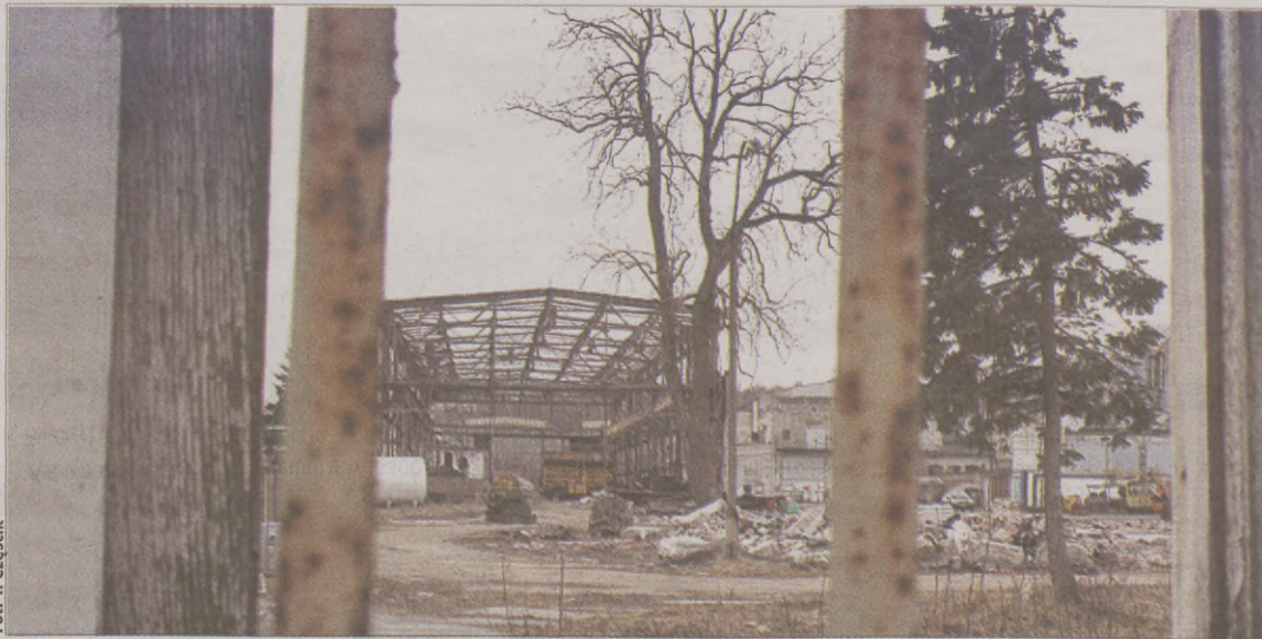
Rozbiórka hali dawnej stoczni jest zwiastunem zmian po zachodniej stronie Ustki.
