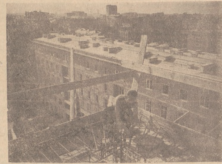
Budowa Marszałkowskiej Dzielnicy Mieszkaniowej Na zdjęciu: przyjacze — Henryk Jóźwiak, wykonujący ponad 200 proc. normy, zbrojny prac. Na dalszym planie budynek 4a. CAF — fot. Nowostelski
