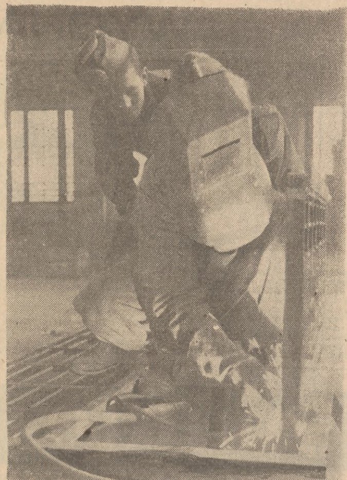
Junacy 30 brygady szkoleniowej PO „SP” przy pracy w stołcu - spawanie Foto L. Prymaka
