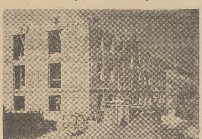
Dla uczczenia XIX Zjazdu WKP (b) i programu wyborczego Frontu narodowego zaloga budowy bloku mieszkalnego przy ul. Dąbrowszczaaków na Wzgórzu Nowotki w Gdyni posta nowa, wykonana w stanie surowym zamkniętym przed terminem, tj. na 28 bm.
