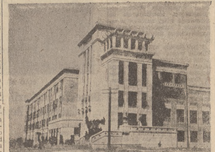
W Sienyang (Makden) w pobliżu Nanku wybudowana została Szkoła Inżynierska, największa tego rodzaju szkoła w Chinach Ludowych. Na zdjęciu: Jeden z budynków Szkoły Inżynierskiej. Fot. — CAP
