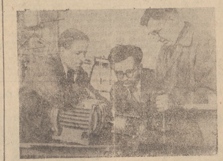
Na zdjęciu: adunkt zakładu technologii drewna mgr inż. Uruski, laborant Ludwik Sieniec i mechanik precyzyjny Wiktor Łukaczewski przy montażu holendra papierniczego, za pomocą którego produkowane są białe papiery do wewnętrznego użytku uczelni. Na dalszym planie (po lewej stronie) widoczny jest fragment doświadczenia kolumny rektyfikacyjnej, służącej do badania polskiej terpentyny; na niej też studenci uczyli się będą zasad rektyfikacji. Kolumna ta jest jedną z tego typu w kraju.
