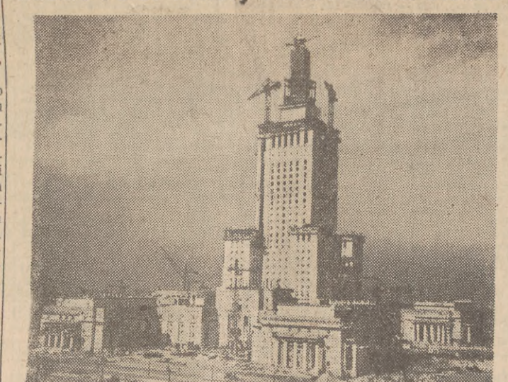
Na wieżochkę Pałacu Kultury i Nauki wznosi się już 12 m. stalowej iglicy.
